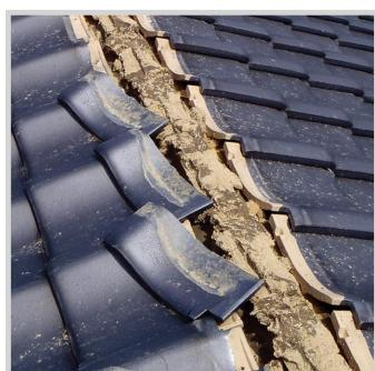
半端瓦の無緊結による脱落
